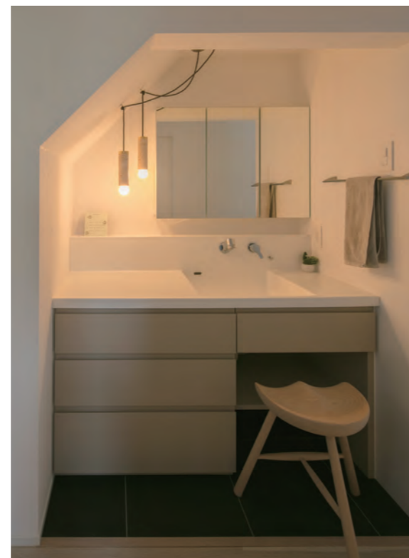
階段下のスペースを有効活用し、廊下に設置した造作洗面化粧台。目立つ場所にあった階段の構造材を撤去し、補強工事を行なったことで開口の広い洗面台となりました。
