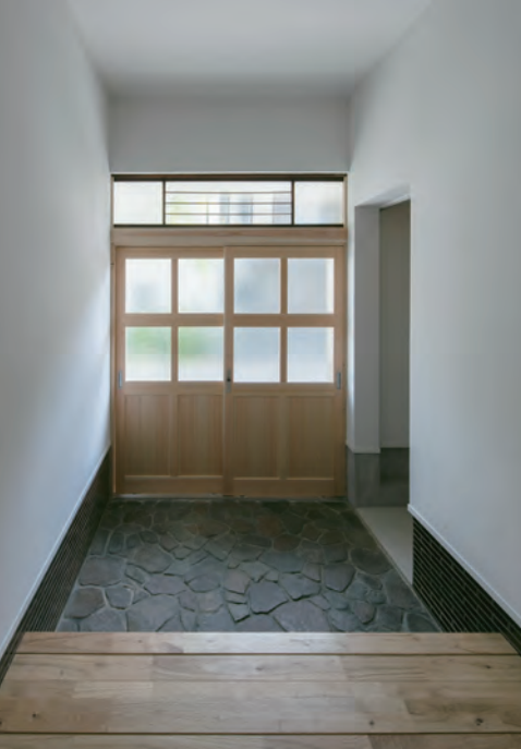
木製の格子戸は経年変化による変色(灰色化)を想定し、既存の欄間や土間の石畳とマッチするものを選びました。
