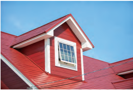
断熱性を高めるために重要視した窓の取り替え。高性能なLow-Eガラスを採用しました。白い窓枠が際立ちます。
