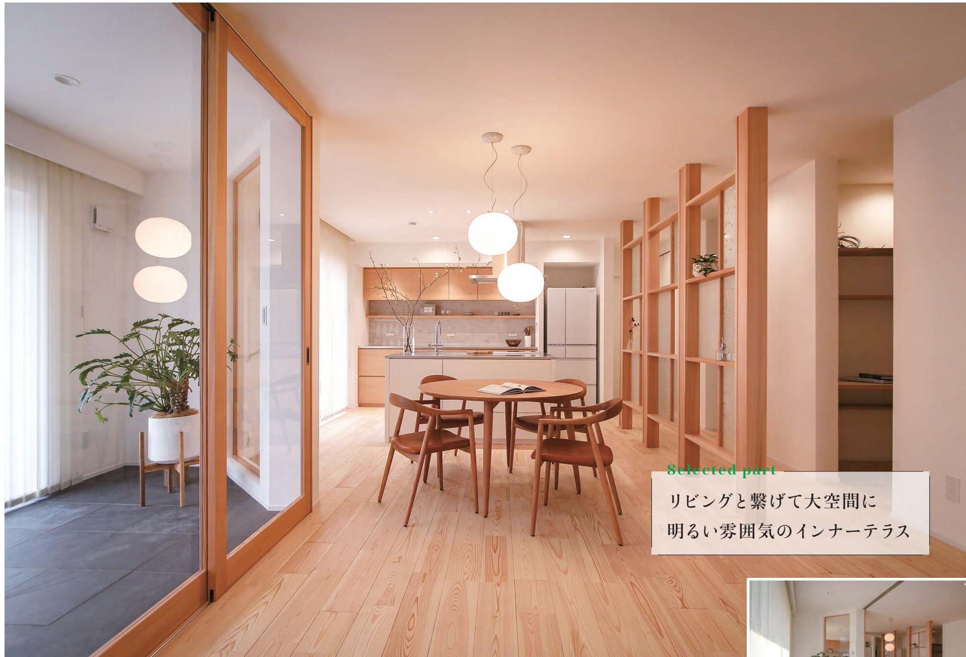
耐震のため必要な柱を活かし、飾り棚を造作。窓や室内建具に使用されていた思い出のガラスをはめこんで、昔の面影も残しました。
