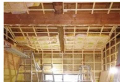
築41年の古い平屋を一度骨組みだけにし、断熱や耐震補強を丁寧に施しました。戸建てリノベに長けた同社の技術が光ります。
